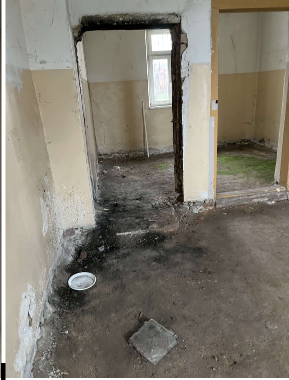
Fot. 3 nadproża w ścianach wewnętrznych
